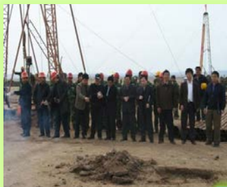
2007年4月18日，气化采煤试验项目开钻
